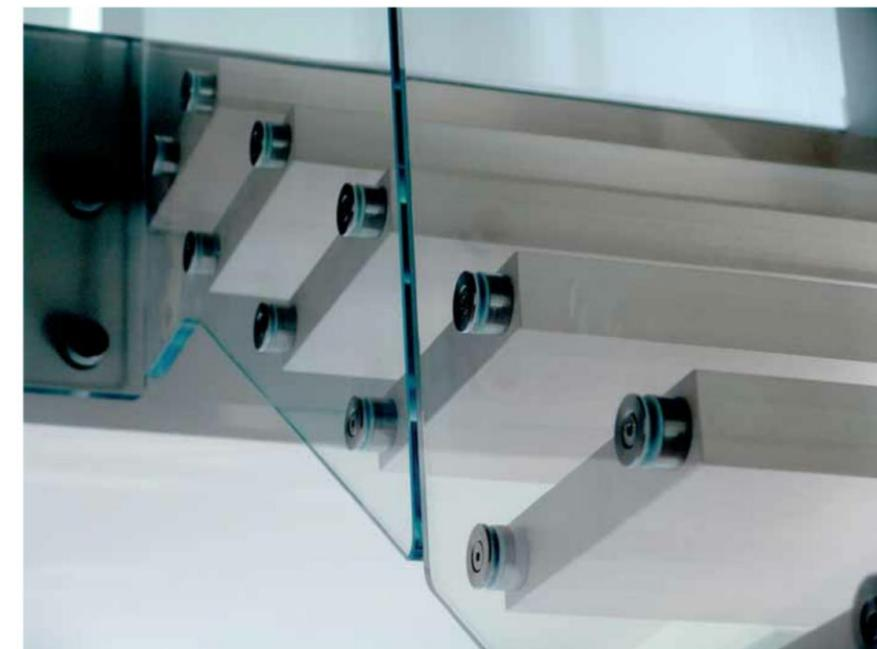
Configurazione pedata in legno lineare, ringhiera autoportante in vetro con fissaggio esterno mod. V1
